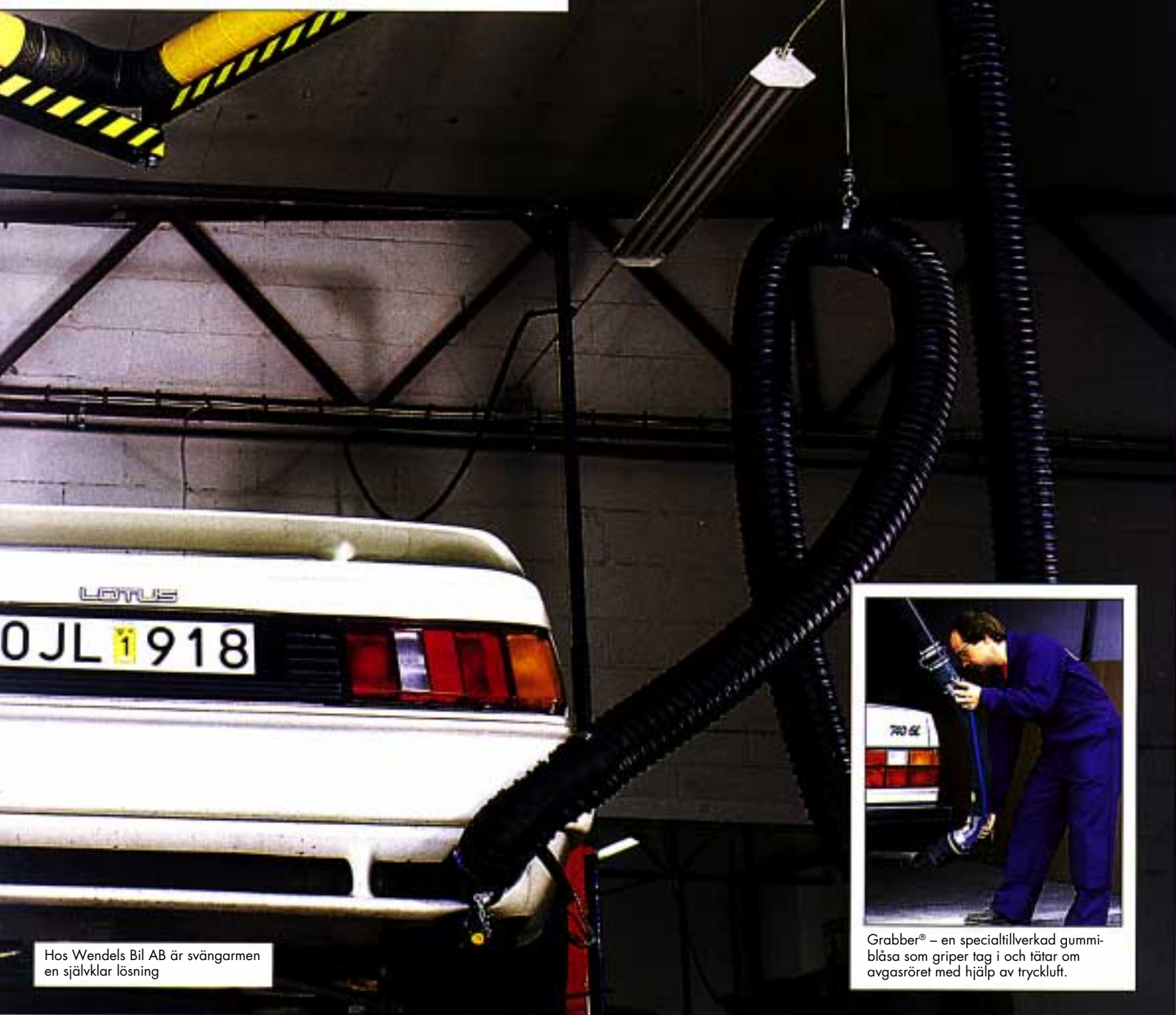
Svängarmens väggfäste är förberett för fläktmontage.
