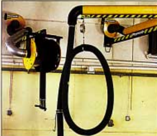
Avgasrulle på rak svängarm. Eller avgasslang med dubbelledad arm medger alltid en effektiv lösning på avgasproblem vid arbetsplatser med kortare körsträckor.
