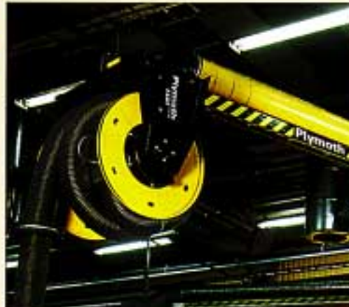
Kombinationen svängarm och avgasrulle med slang i 6 m standardlängd ger en överlägsen flexibilitet och räckvidd.
